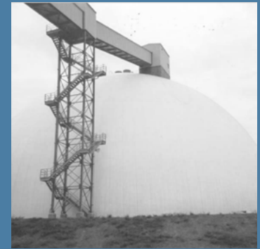
National Gypsum Gibsonton, Florida, USA
